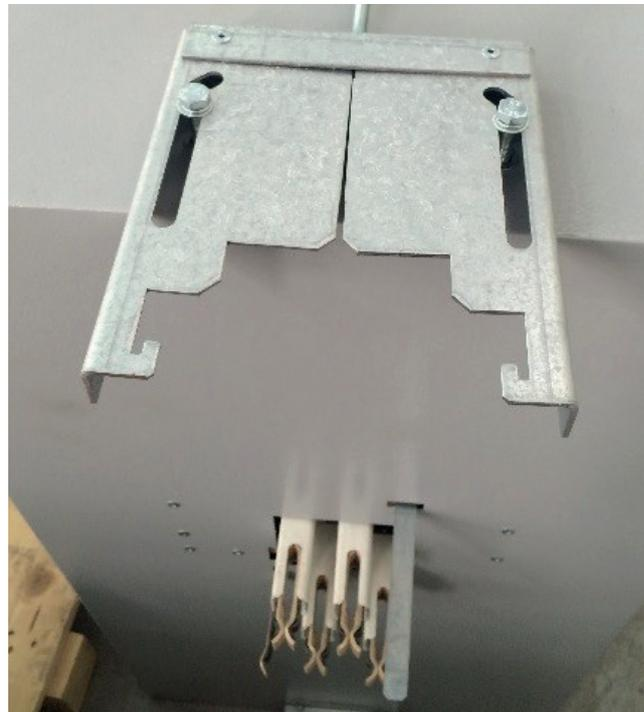
Esse sistema inserção e extração segura e independente da força humana consiste em rosca sem fim que insere e extrai automaticamente a caixa do acoplamento ao barramento, apenas girando em sentido horário para inserção e anti-horário para extração
